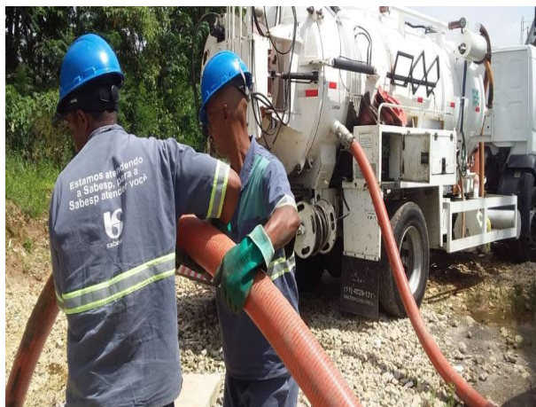
Foto 13: Limpeza da fossa séptica do canteiro 2 (SABESP) (16/02/2023)
