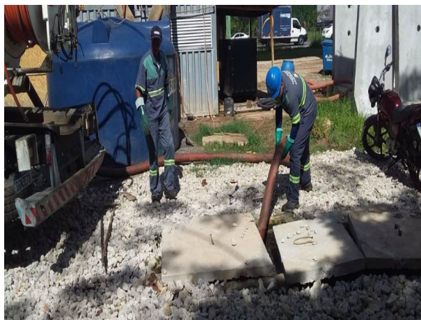
Foto 3: Limpeza da fossa séptica (Sabesp) (25/11/2022)
