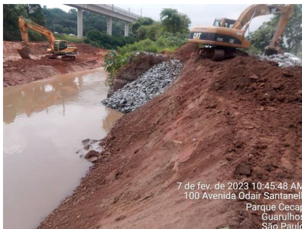
Foto 11: Tratamento de erosão (07/02/2023)
